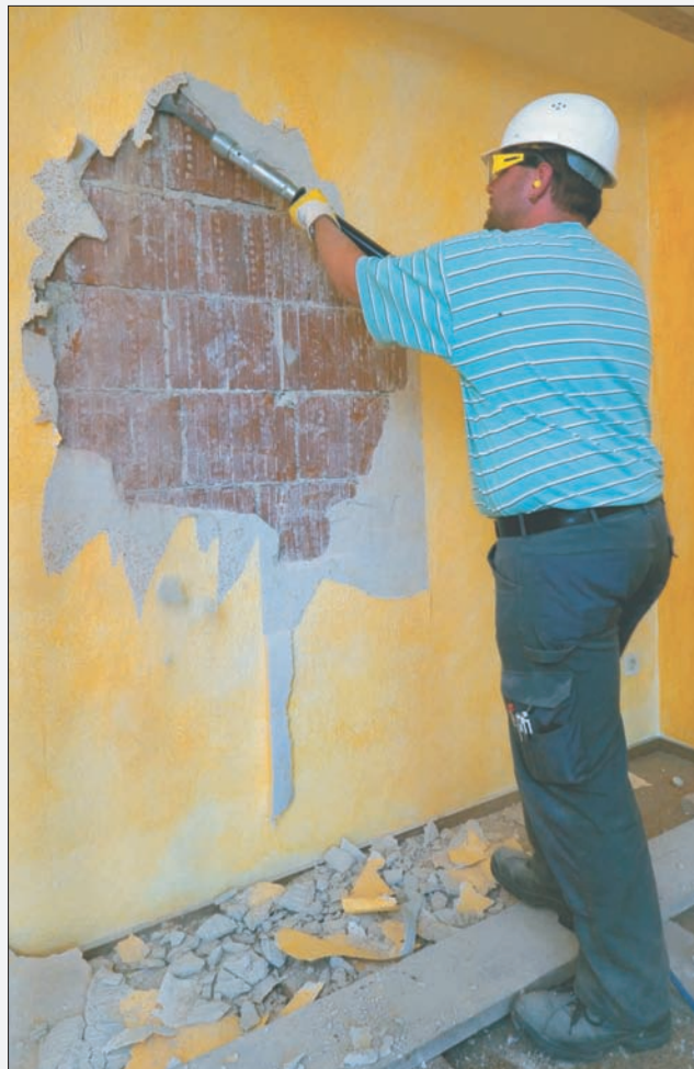
Entfernen von Innenputz - komplette Raumhöhe ohne Gerüst, ohne Bücken
