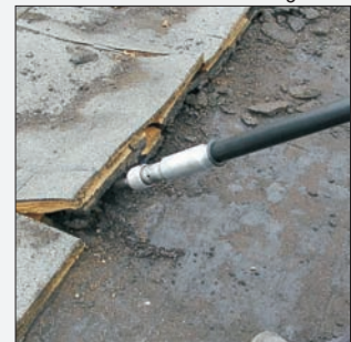
Bitumen aller Art abtragen
