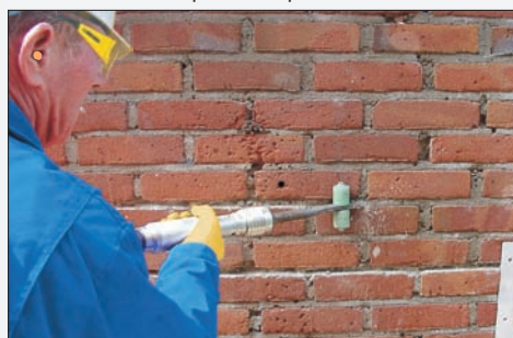
Räumen von Fugen in gleichbleibender Tiefe
