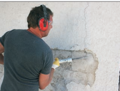
Abschlagen von Aussenputz
